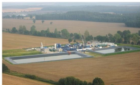
Łebień LE-2H wellsite (source: 3legsresources)
