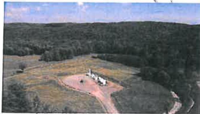
Une plateforme multipuits (source : eCorp)
